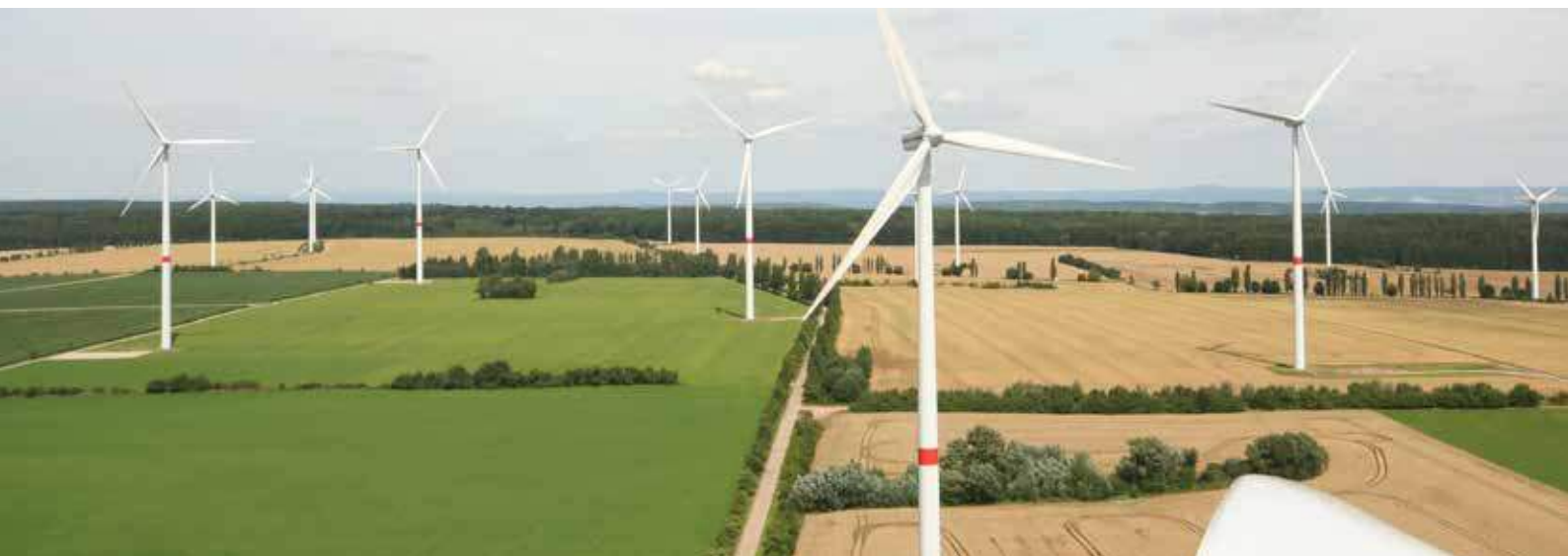
Windpark Großenehrich, Thüringen
